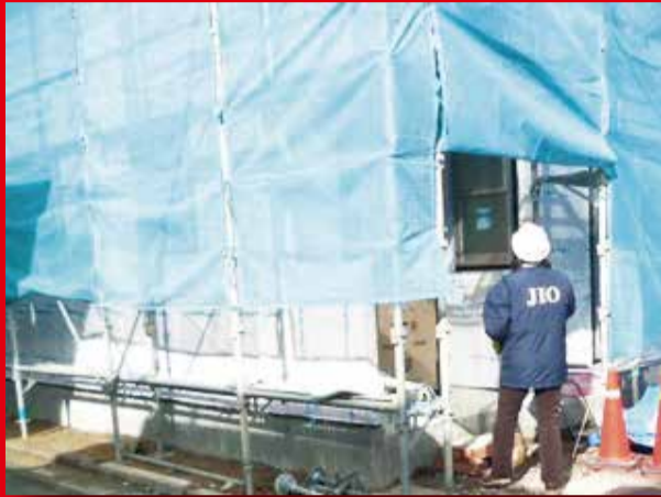
JIO検査員による現場審査
