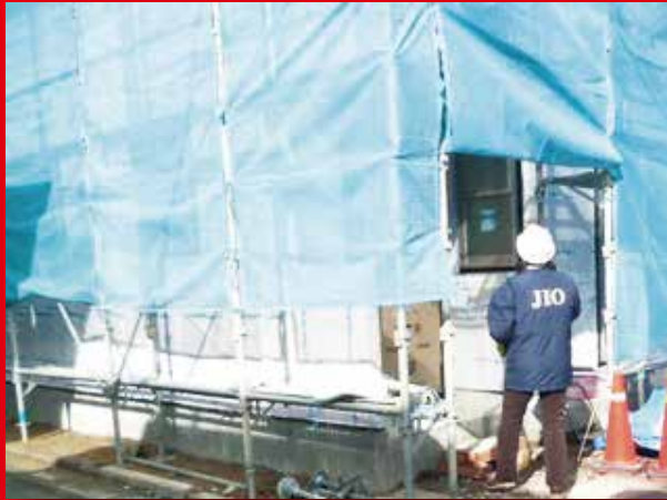
JIO検査員による現場審査
