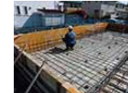
JIO配筋検査
