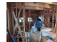
JIO中間検査
